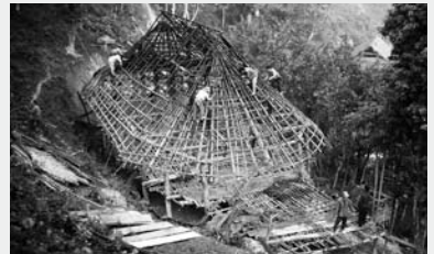
「亀の甲」型家屋の解体
