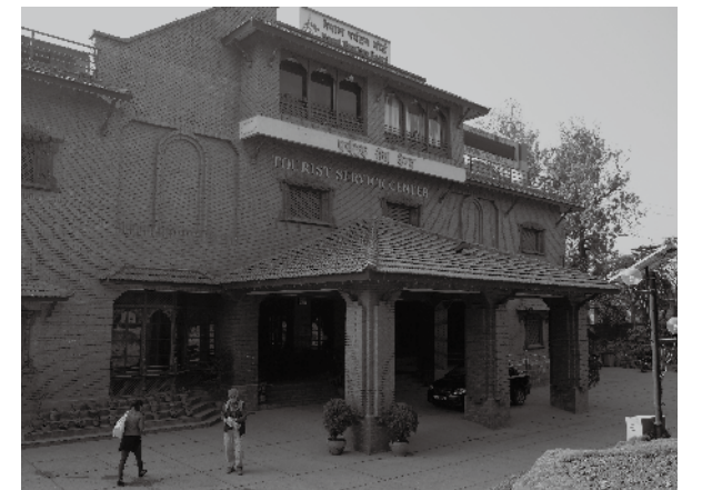
ネパール民族誌博物館が入るツーリスト・サービス・センター(2017年)
