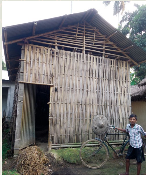
タケでつくった壁材が使用されている家屋（インド、アッサム州、2017年）
