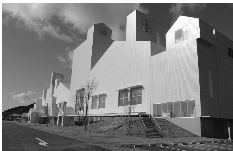
2021年春に開館を控えた文化施設「マルホンまきあーとテラス(石巻市複合文化施設)」の外観(2021年1月31日)
