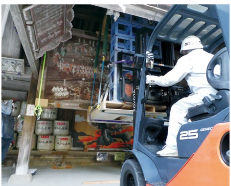
絵馬の再設置作業(提供:文化創造巧芸, 2021年)
