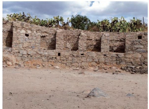
図4 カピヤパタ地区にあるD字型建築の壁龕（修復後）
