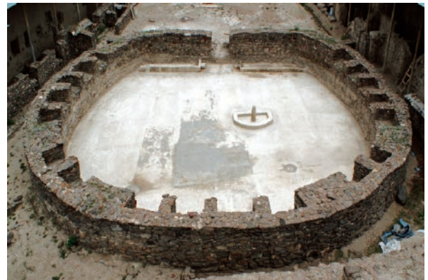
図2 ポゾランを用いた修復が施された日時計の床
