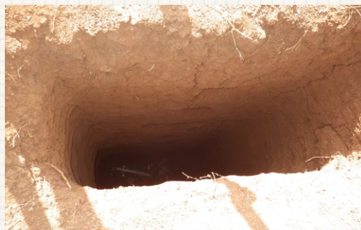
建設中のポットン便所。この深い穴に落とされた物は拾われることはない(2015年)
