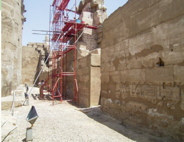
ルクソール神殿に組まれた足場。この足場の裏にあるレリーフを撮影しに来たのに、叶わなかった(エジプト ルクソール、2005年)
