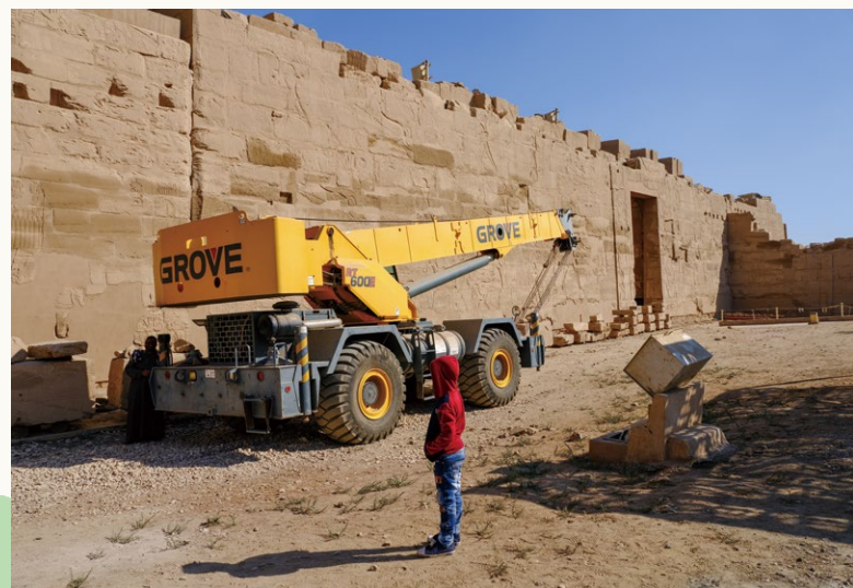
カルナク神殿に停まっていたクレーン車(エジプト ルクソール、2020年)
