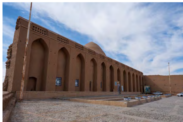
メイボドのヤフチャール。遮光壁の奥に氷室のある円錐形のドーム、手前に製氷池がある。現在は観光地になっている(イラン メイボド、2025年)
