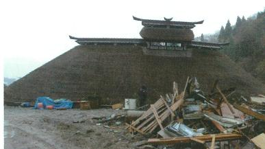
写真2 被災して屋根だけが残った
