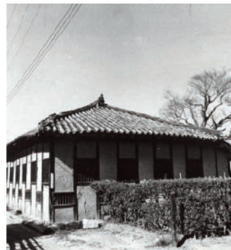
写真1 移築前の鋳物工場
