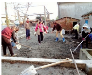
写真 11 バス停の建設
