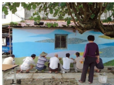
写真7 モザイクタイルを壁に貼る
