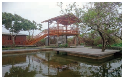
写真 13 水保局の改修
