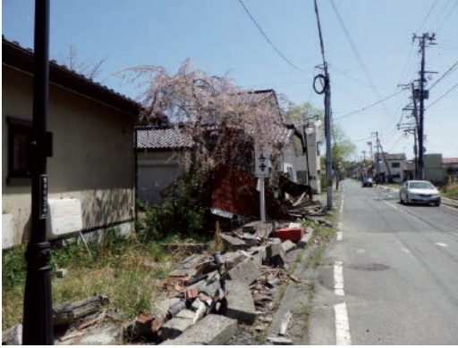
図9 倒壊した光善寺の山門（2021年）
