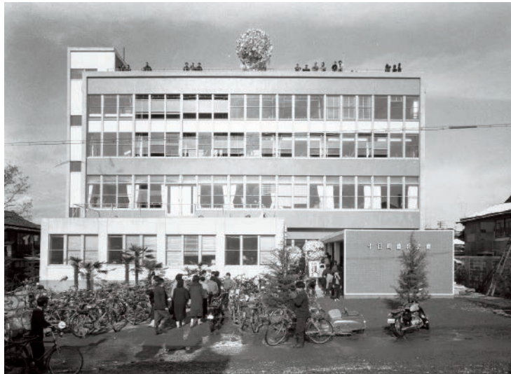
写真7 昭和33年 十日町織物会館の竣工
