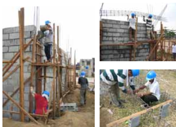
図 2 住宅建設過程のモニター
