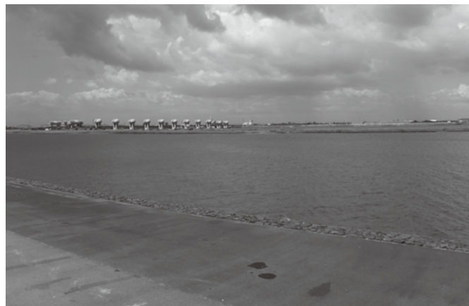
揖斐川河口付近・正面は長良川河口堰
