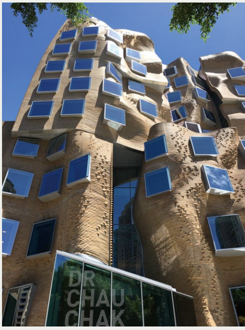
非営利の世界的中心的関心は寄付。寄付で建てたシドニー工科大学の建物。世界的建築家フランク・ゲーリーの作品でランドマークになっている。寄付のあるところに会計の話題が付いてまわる(2018年)
