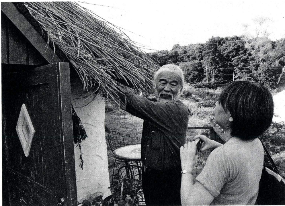
稲ワラを利用して通気性と断熱性を高めたモデルハウスを紹介する藤村靖之さん(中央)＝栃木県那須町
