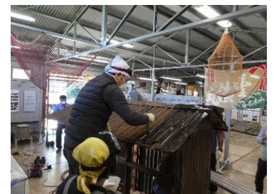
ネコ実験小屋の錆止め作業の様子
