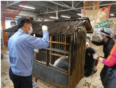
【5】水俣病歴史考証館「ネコ実験の小屋」の修復作業
